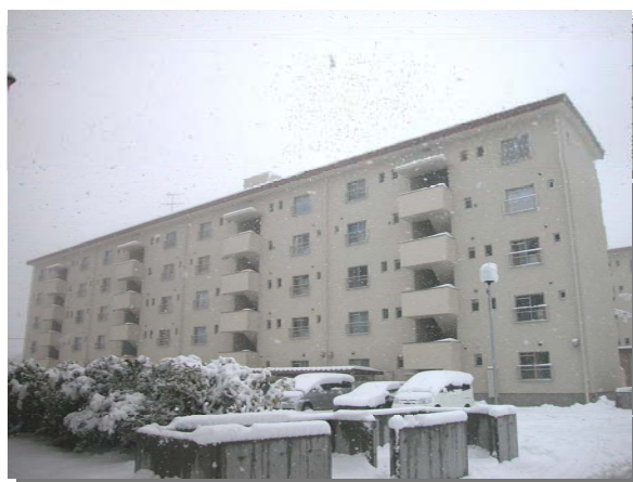
北側外観（改善後）
