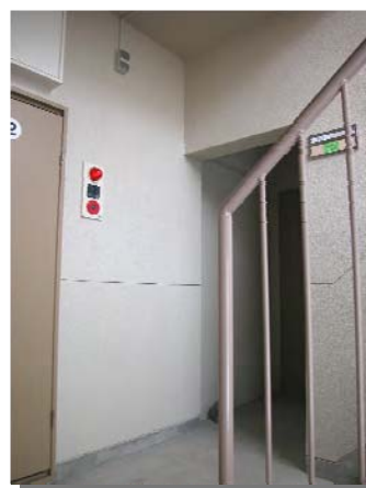
玄関アプローチ（改善後）
