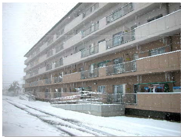
南側に増築された車椅子使用者用スロープ（改善後）
