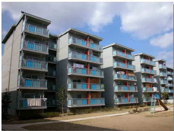
南側外観（改善後）
