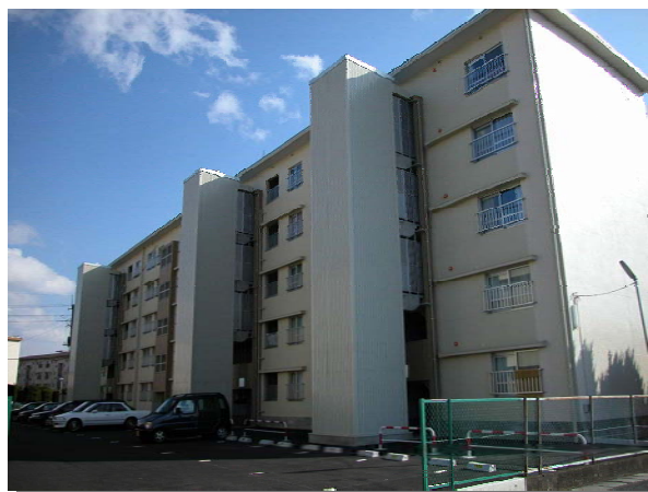
北側外観（改善後）
