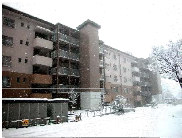
北側外観（改善後）
