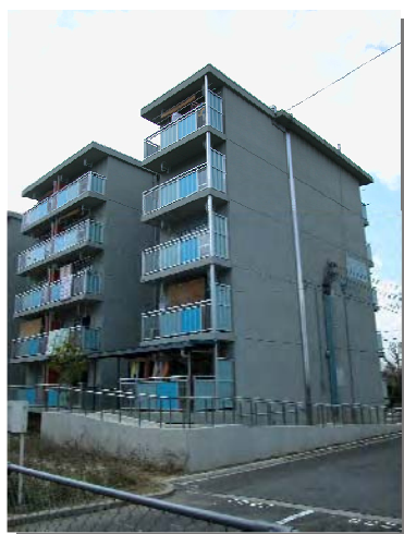
車椅子住戸用スロープ
