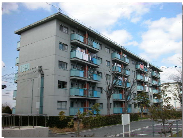
南側外観（改善前・3階段室住棟）
