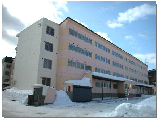
北側外観（改善後）
