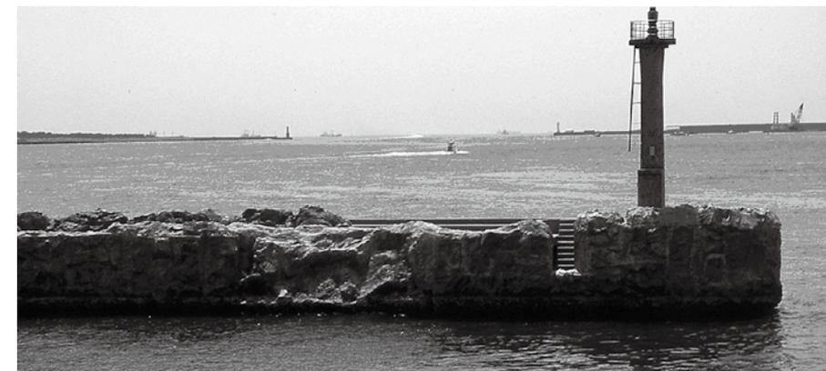
写真1 人工的疑石仕上げとした景観コンクリート<sup>8)</sup>
