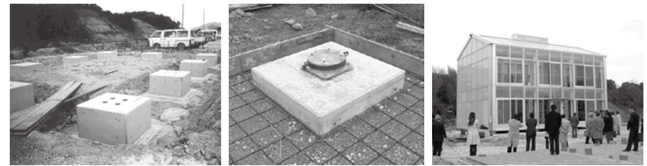
写真1 完全リサイクル住宅に用いられたセメント回収型—完全リサイクルコンクリート<sup>6)</sup>
