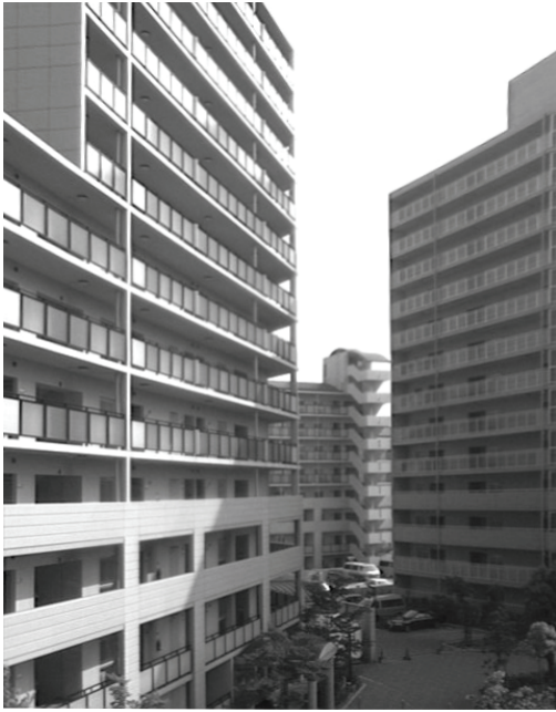
図 2-6 1980 年以降に建設された 典型的な高層集合住宅
