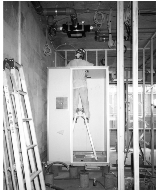
図2-4 取り付け工事中のバスユニット
