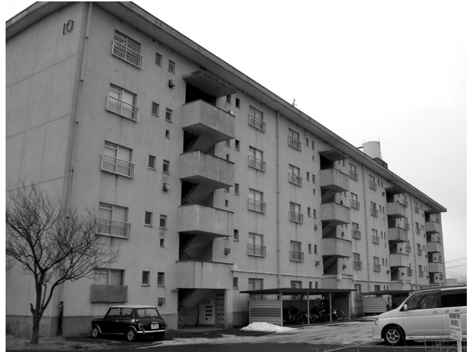
図 2-3 1970 年代初頭に建設された 階段室型集合住宅の外観
